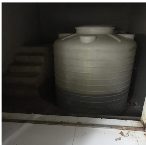
盐酸罐区围堰
