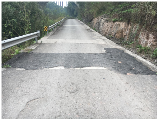
配水管线穿越道路恢复情况
