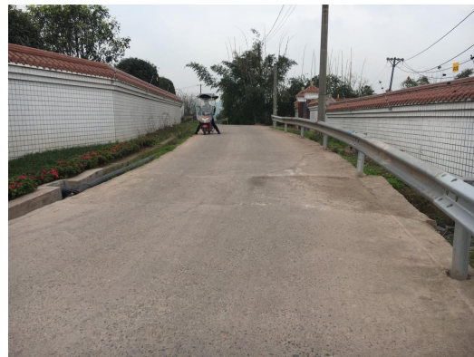
提水管线穿越道路恢复情况
