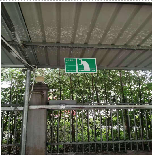
生化池排口标识牌
