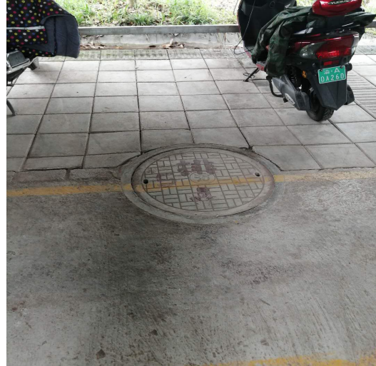
厂区西侧生化池
